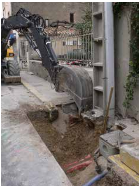
Tranchée ouverte - LA FARE LES OLIVIERS
