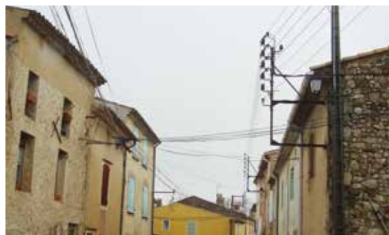
Avant : LE PUY-SAINTE-REPARADE - Rue de la place
