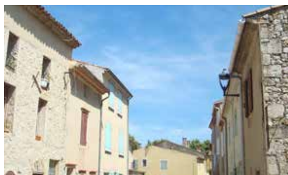
Après : LE PUY-SAINTE-REPARADE - Rue de la place
