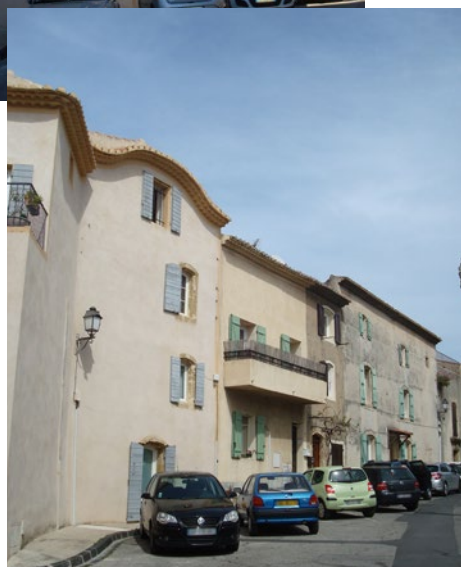
Avant/Après : LANÇON DE-PROVENCE - Boulevard Pasteur
