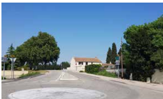
APRÈS : ROGNONAS - Avenue Général de Gaulle
