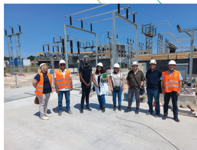
Travaux de modernisation et sécurisation du poste source de Vitrolles
