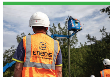
Novembre 2021 - Chantier rénovation programmée à Arles
