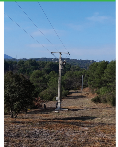
Vue d'une ligne électrique sur Fuveau après une opération d'élagage.
