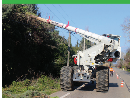
Utilisation de la Jaraf par un prestataire sur un chantier élagage à Miramas.
